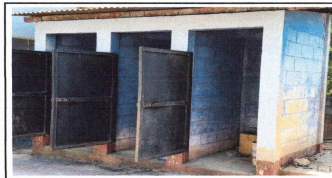
Foto 6: Se observa al módulo de letrina en mal estado y desprendimiento de pintura.
