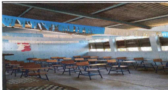
Foto 5: Se observa el deterioro de la estructura portante y ventanerías de balcones oxidado módulo 2.
